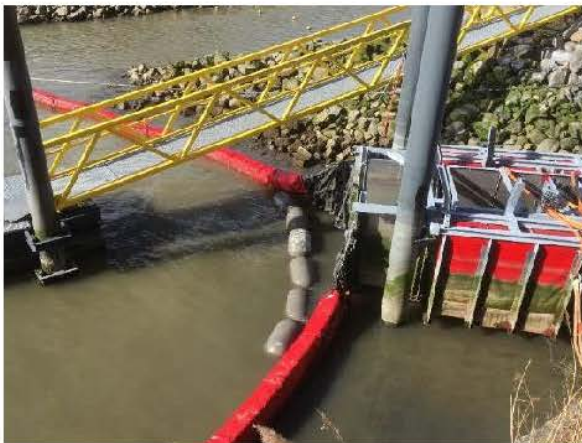
Figuur 3-9: Spudpalen voor het afmeren van de plasticvanger. Op de spudpalen zijn stoppers met dempers geplaatst (1) waarop het systeem rust bij laag water.
