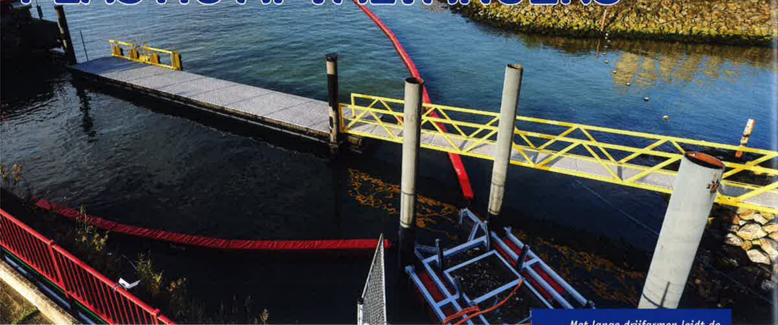
Met lange drijfarmen leidt de Catchy van Allseas het drijvende afval naar een opvangbak.
