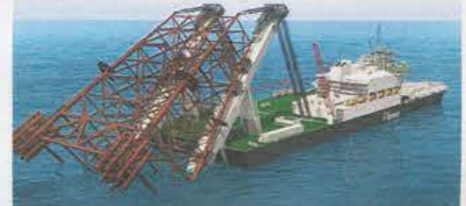
5 Het frame wordt plat op het dek gelegd.
