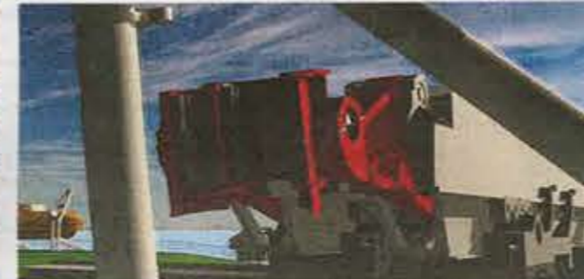
3 Acht klampen die elk 6000 ton kunnen tillen klemmen zich om de pijlers van de installatie.
