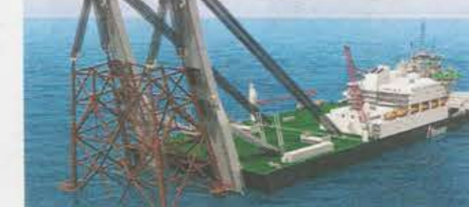
4 Het frame wordt met klampen bevestigd aan de kantaal/hefkrana.
