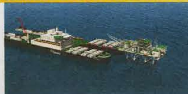
1 De Pieter Schelte vaart op eigen kracht naar de installatie die verwijderd moet worden.
