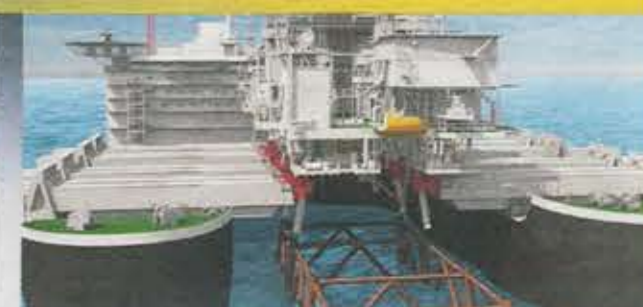
6 De klampen houden de installatie stevig op zijn plek en de Pieter Schelte vaart weg van het frame.
