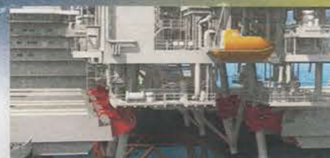
5 Wanneer de klampen gezekerd zijn wordt door het legen van de ballasttanks van het schip (het schip komt hoger in het water te liggen) de installatie van het frame getild.
