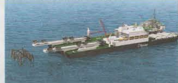
1 Om het offshore-frame van de bodem te tillen wordt de Pieter Schelte met haar achterstevens naar het frame manoeuvreerd.
