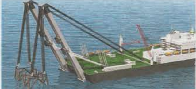
3 Takels worden aan de bovenkant van het frame bevestigd.
